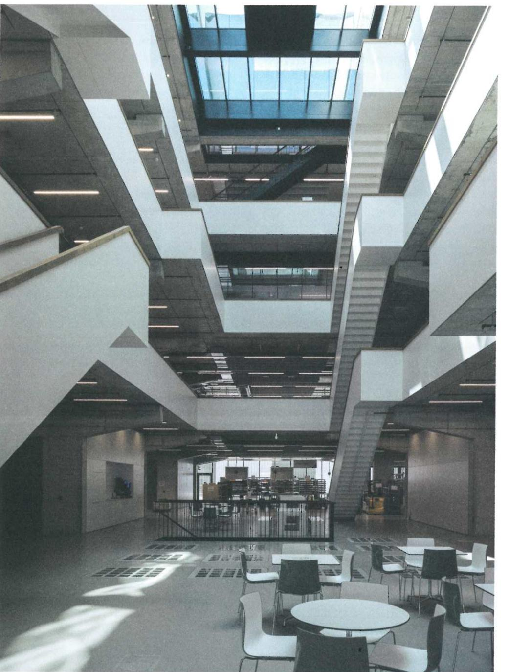
Für die Firma Komax in Dierikon haben Graber & Steiger bis 2020 einen sechsgeschossigen Erweiterungsbau errichtet. Die offene Struktur ermöglicht flexible Nutzungen und Anpassungen mit geringem Aufwand. Ein Atrium schafft eine vertikale Verbindung zwischen Produktion, Logistik, Büros und Sitzungsräumen.
