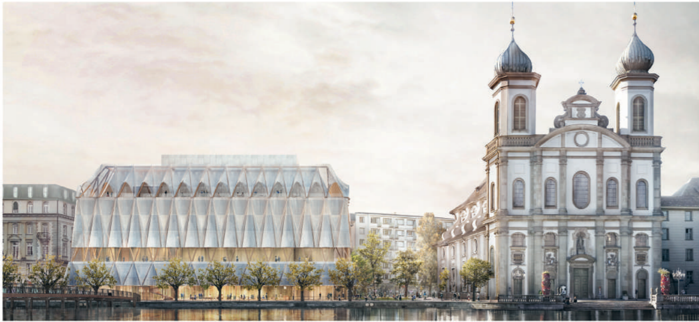
Neubau mit zeltartigem Dach
