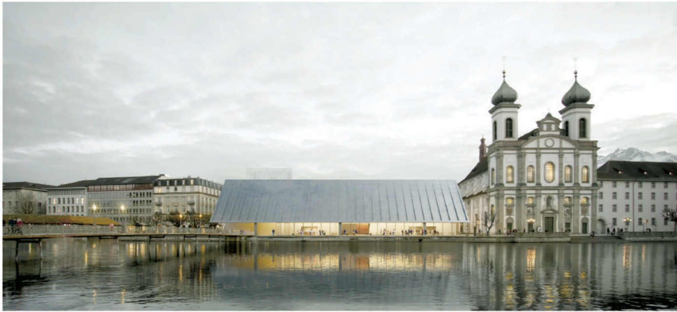
Ein grosses, geneigtes Dach bestimmt den Ausdruck des neuen Theaters.
