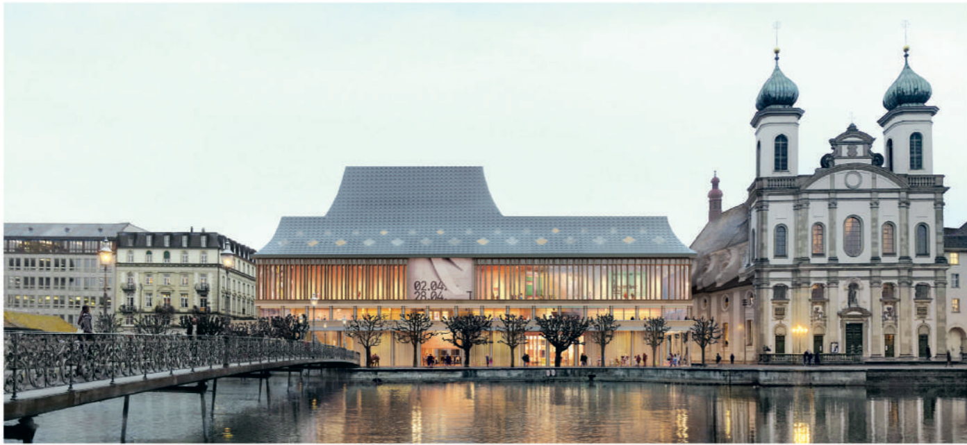
Die Dachform des Neubaus erinnert an die Mansardendächer des vergangenen Jahrhunderts und soll zwischen den Nachbargebäuden und Jesuitenkirche vermitteln.
